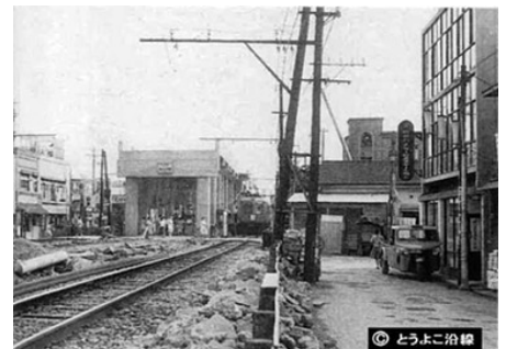
昭和35年頃?高架工事中(手前渋谷方向)
